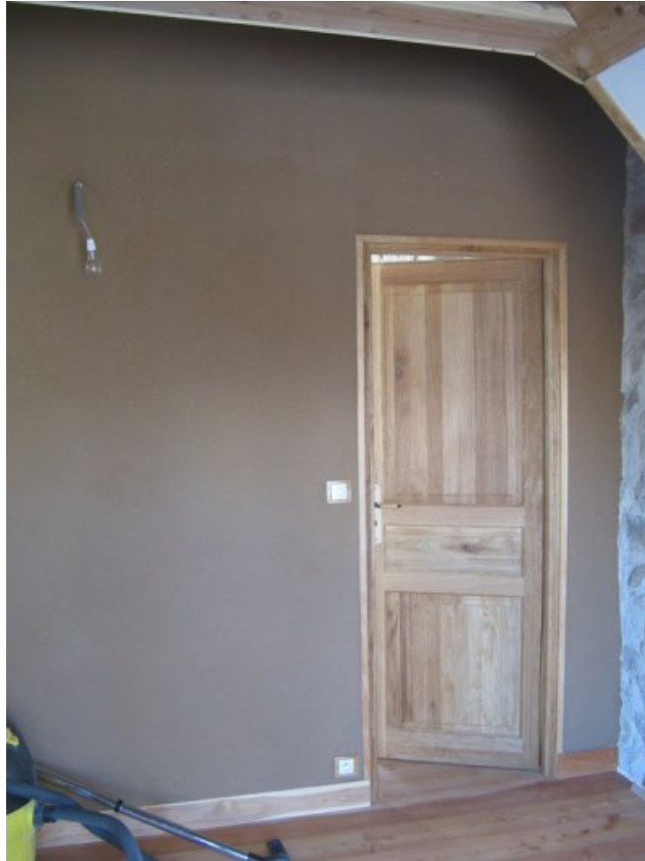
Enduits terre, plancher en mélèze,escalier en chêne...
