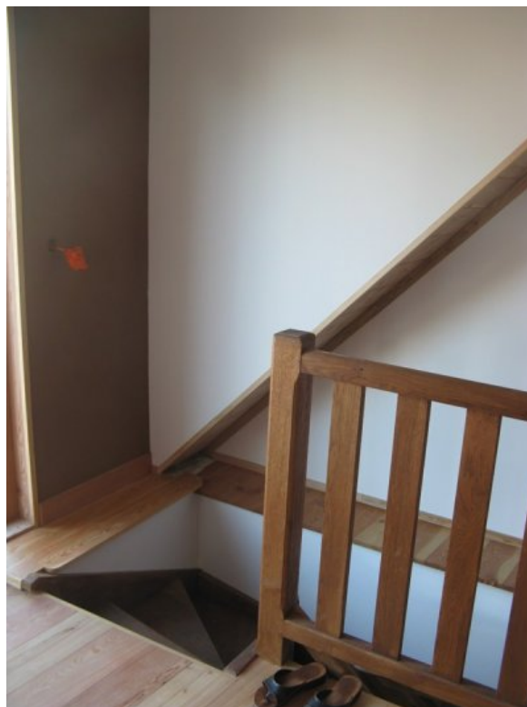
Enduits terre, plancher en mélèze,escalier en chêne...
