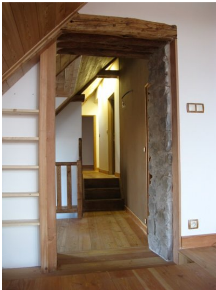
Enduits terre et intégration d'une porte de meuble ancien
